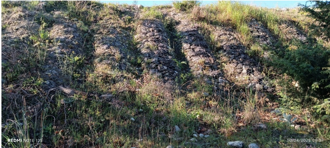
Εικόνα 3: Επένδυση πρανών με συρματοκιβώτια (sarzanet).
