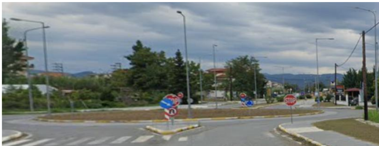
Σήμανση (οριζόντια και κάθετη) στη συμβολή Αγ. Νικάνδρου με τον υφιστάμενο κόμβο
