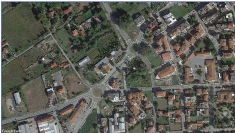
Αεροφωτογραφία υλοποιημένης διαμόρφωσης κυκλικών κόμβων επί της οδού Αγ. Νικάνδρου
