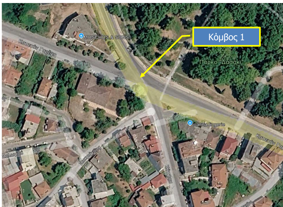
Εικόνα 1: Υφιστάμενη κατάσταση κόμβου 1 - Απόσπασμα από Google Earth
